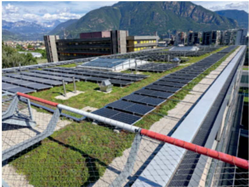
Solargründächer sind eine Kombination aus Dachbegrünung und Photovoltaik
