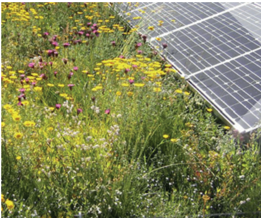
Eine extensive Dachbegrünung wiegt im wassergesättigten Zustand zwischen 80 und 150 kg pro Quadratmeter.
